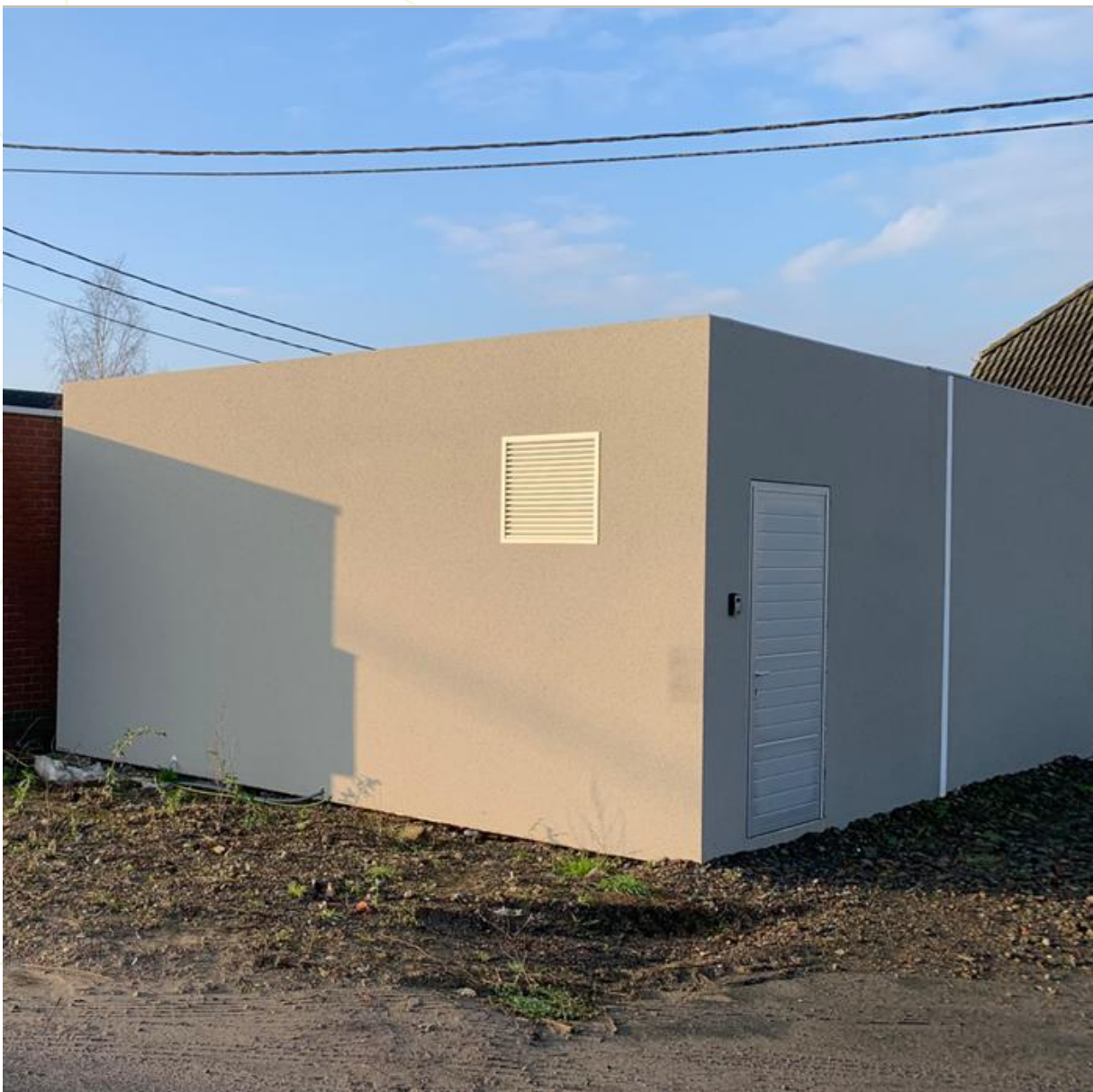
Figuur 11: de technische cabine
