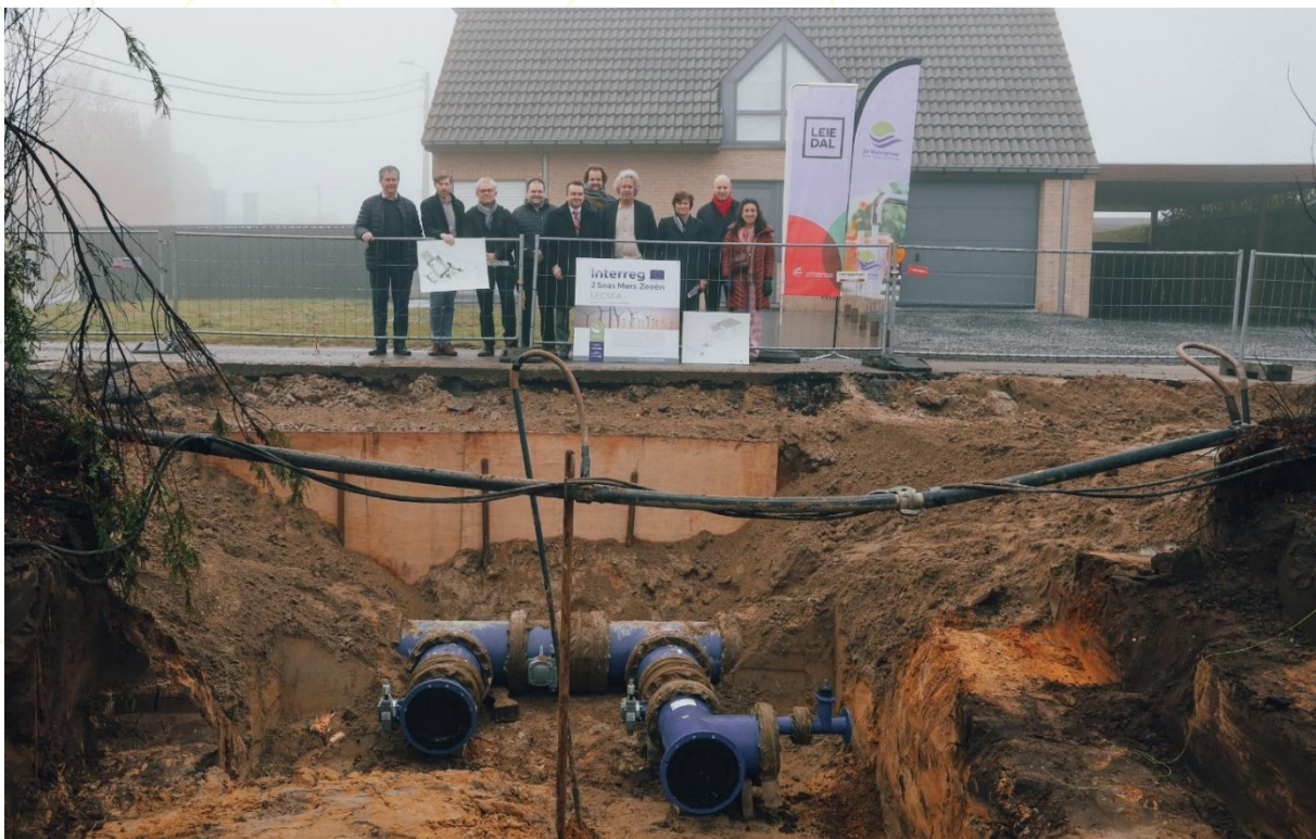
Figuur 10: de realisatie van de bypass van de drinkwaterleiding
