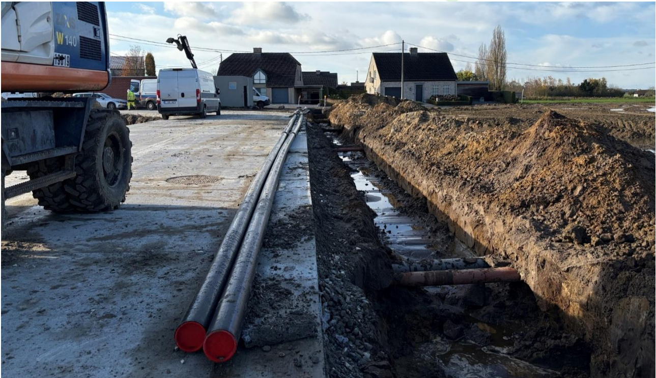
Figuur 12: realisatie van het secundaire circuit op de site
